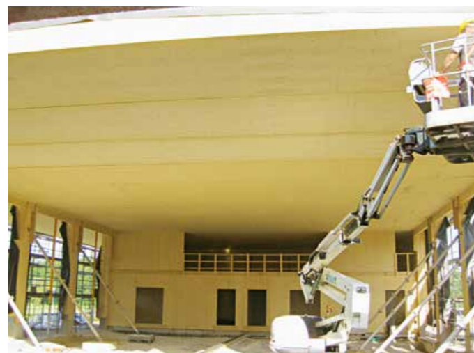
▲ Das Tragsystem des neuen Betriebs Hofes überspannt das komplette Gebäude und das Vordach – insgesamt 25 m Tragweite
